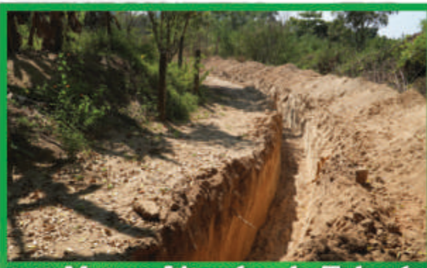
340 Metros Lineales de Tubería
